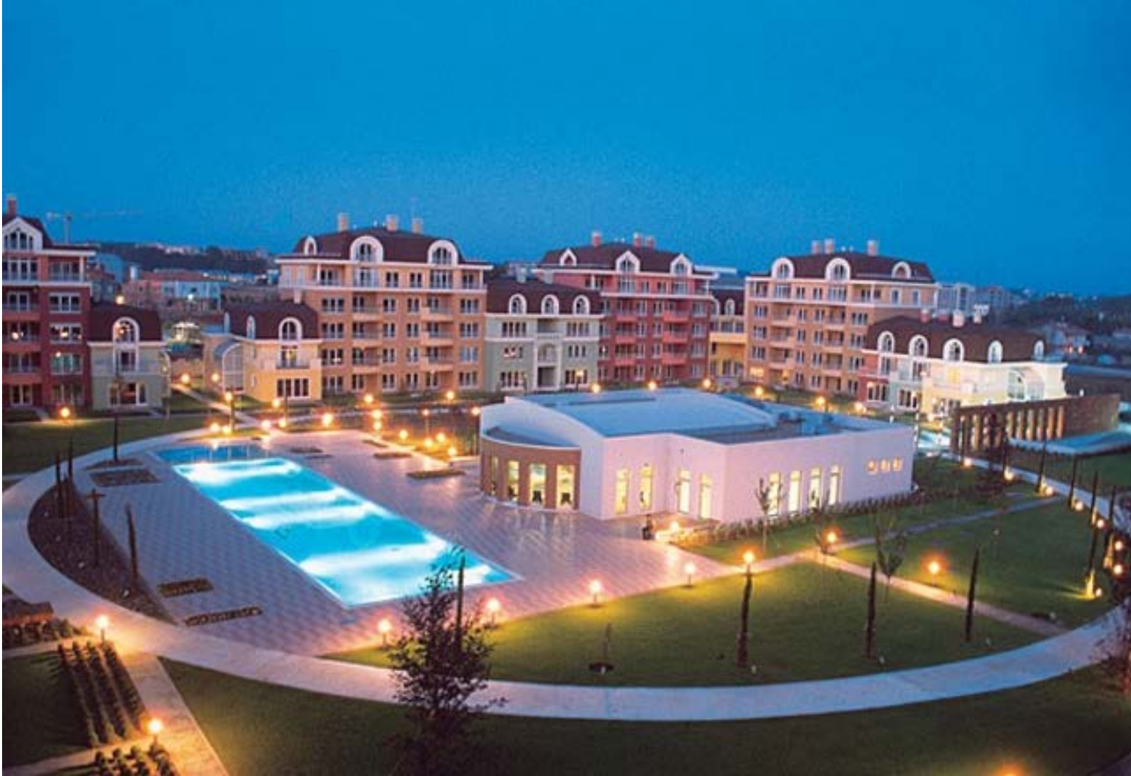
KEMERBURGAZ KONUTLARI 1.ETAP
